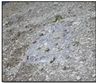
ビニールの設置
