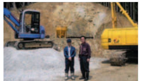
茂浦～浦田トンネルの工事面
