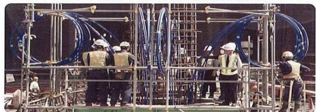
地中熱利用・基礎杭利用方式施工時 Geothermal heating and cooling system・Structural pile foundation construction
