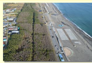
写真3 被災約20か月後 クロマツの多くが枯死 (モーターパラグライダーで撮影。)
