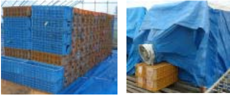
コンテナの積み方 ファンの取付
