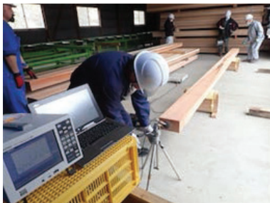
公共建築に使用する建材の強度測定
