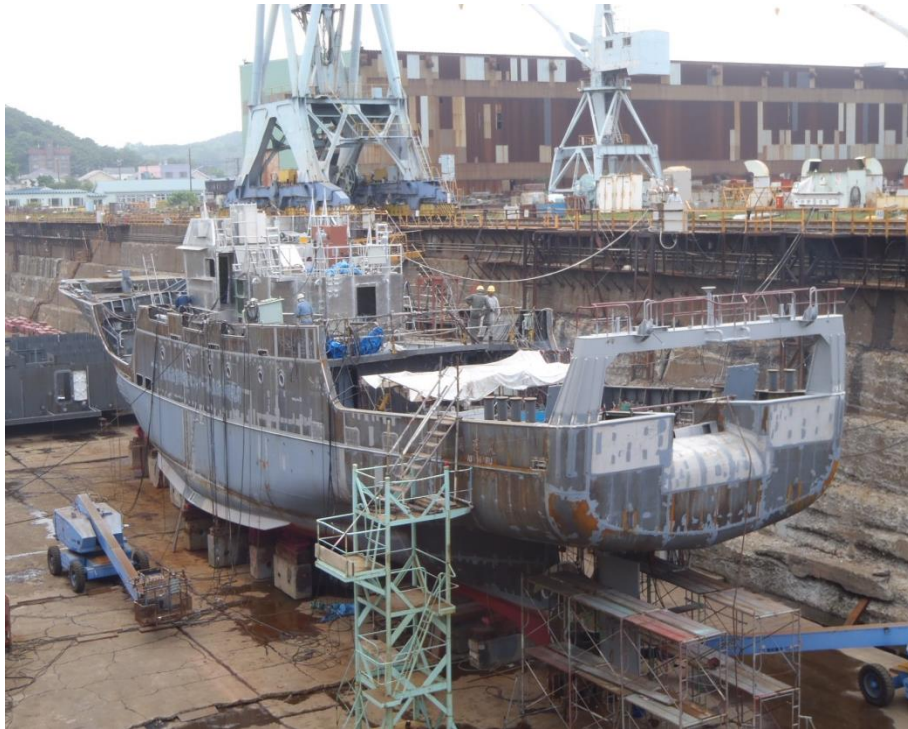
新開運丸の建造風景
