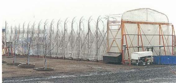
降雨遮断施設が閉じている状態
