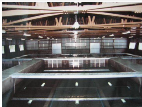
さけふ化場の内部
