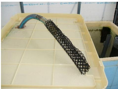
写真7 濾過槽への給水ホース先端部と濾過槽の蓋
