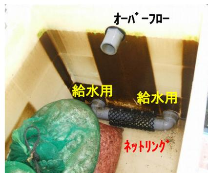
写真 5 濾過槽内側の配管
