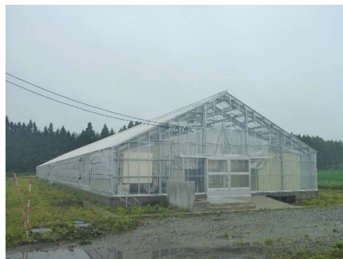
完成した増殖ハウス
