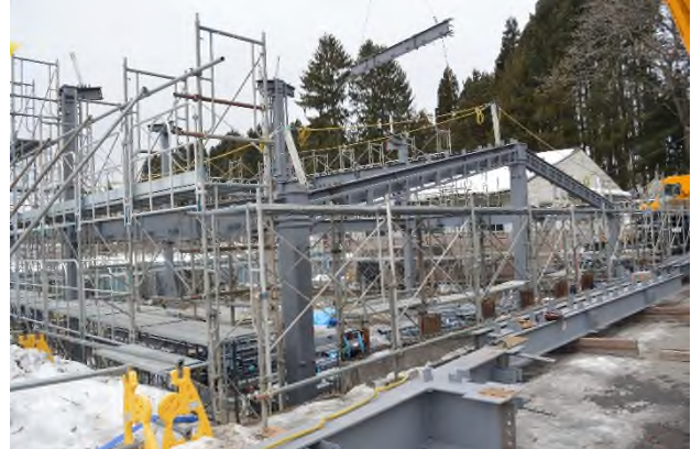
建設中の新ふ化棟
