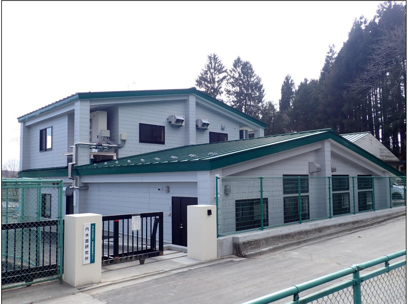
内水面研究所 新ふ化棟
