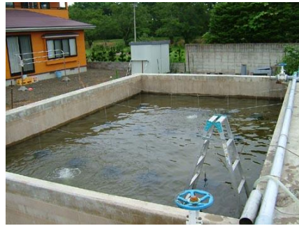
種苗生産に使うコンクリート水槽
