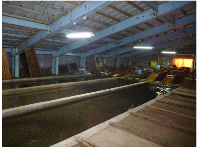
老部川さけふ化場
