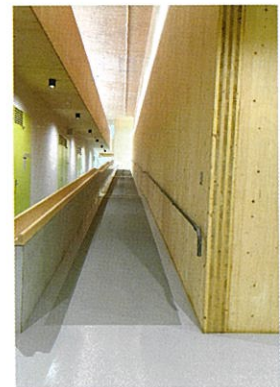
図2 九州支所の共同実験棟（CLTパネル使用）
