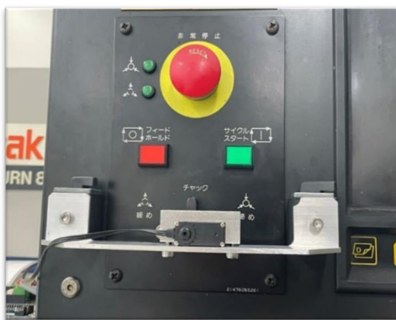
写真 2 操作盤チャック部分
