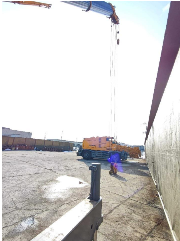
図 2 6 実証実験の様子（ブームを下げているところ）
