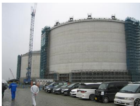
建設中の八戸 LNG 輸入基地
