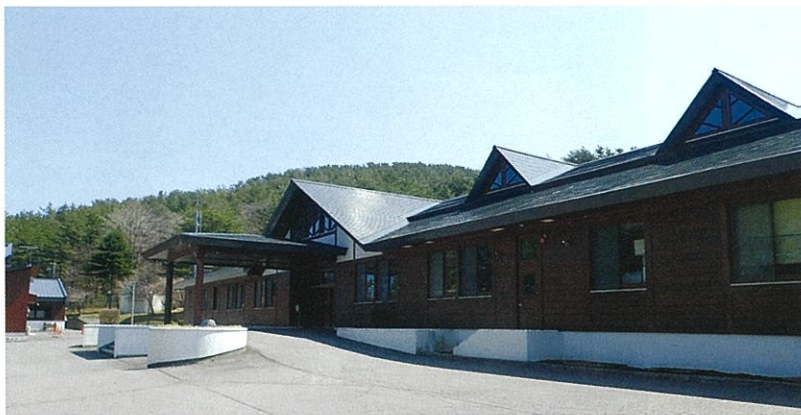
現在の林業研究所の研究管理棟
