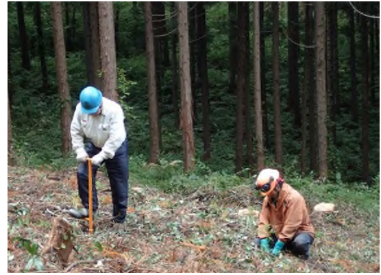
写真5 コンテナ苗植栽状況
