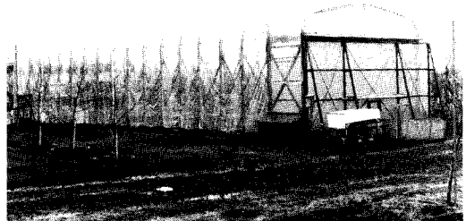
写真2 降雨遮断施設が閉じている状態
