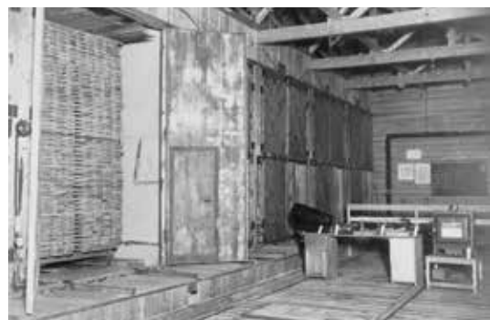
木工指導所の木材乾燥室(昭和20年代中頃)
