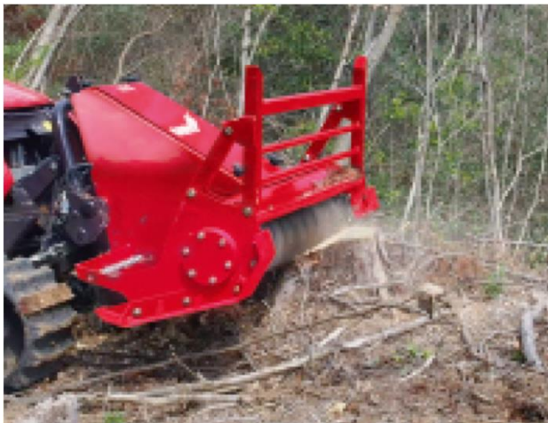
伐根粉碎作業
