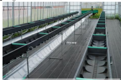
完成した高設ベンチ(所内)
