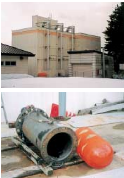
図2 濾過棟、逆洗管が3本見える。(上)、ポリピックとその発射台 (下)
